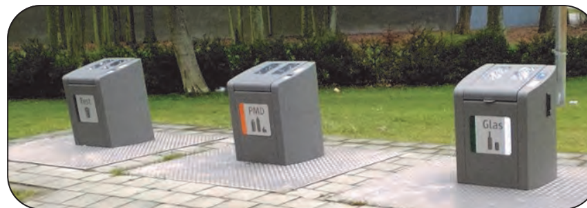
Ondergrondse afvalinzamelsystemen voor glas, pmd en restafval
