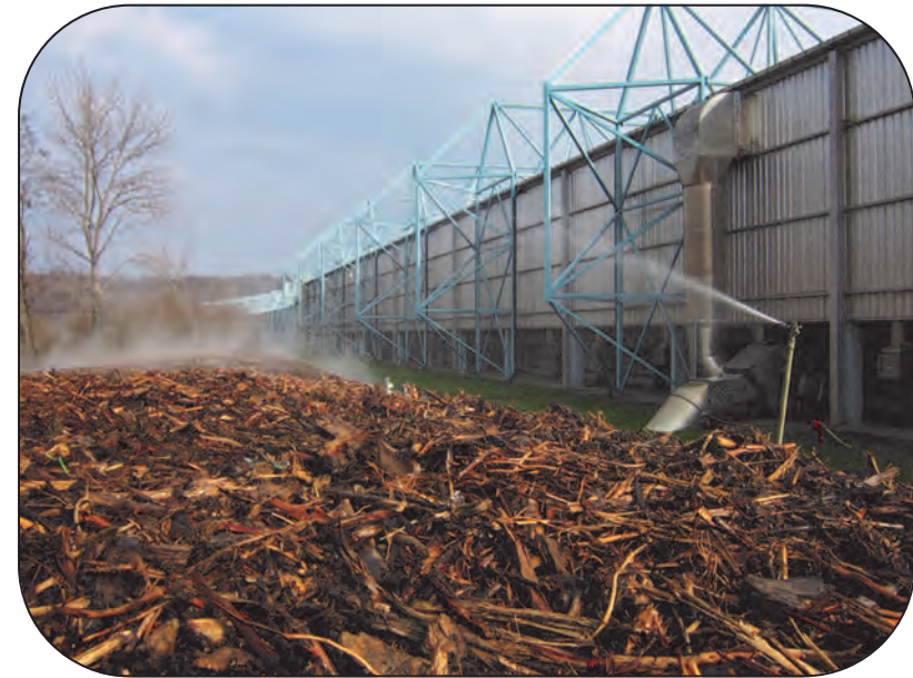
De biofilters worden vanaf 2016 bevochtigd met gezuiverd afvalwater van buurbedrijf Aquafin.
